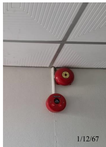
รูปที่ 18 สัญญาณระบบเตือนภัยภายในอาคาร
