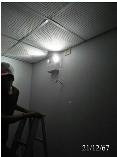
รูปที่ 21 การติดตั้งระบบไฟฟ้าฉุกเฉิน (เปลี่ยนจากของเดิม)
