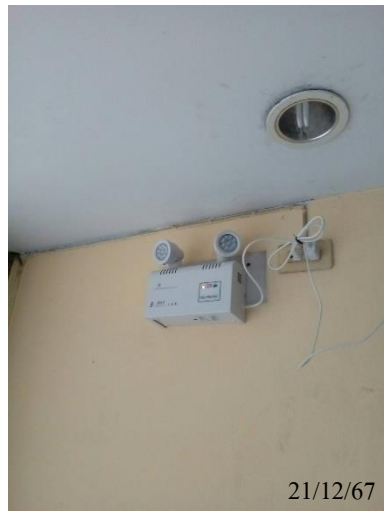
รูปที่ 20 ระบบไฟฟ้าสำรอง
