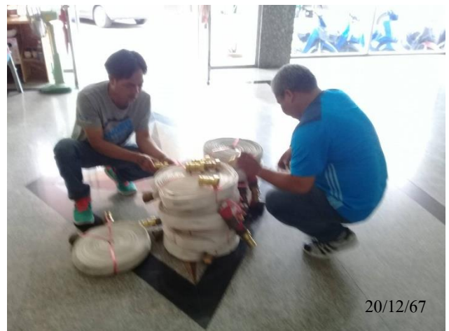
รูปที่ 16 การติดตั้งเปลี่ยนสายดับเพลิงภายในอาคาร (เปลี่ยนจากของเดิม)
