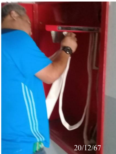
รูปที่ 16 การติดตั้งเปลี่ยนสายดับเพลิงภายในอาคาร (เปลี่ยนจากของเดิม)
