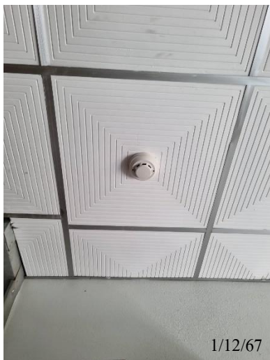
รูปที่ 19 เครื่องตรวจจับควัน (Smoke Detector)
